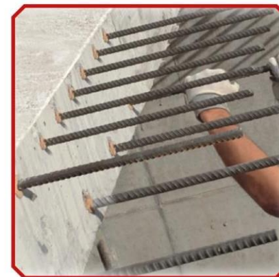
Устройство арматурных выпусков
