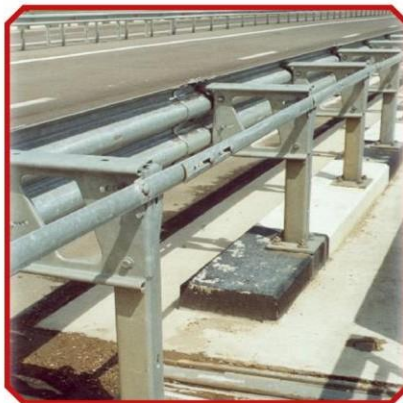
Крепление барьерного ограждения
